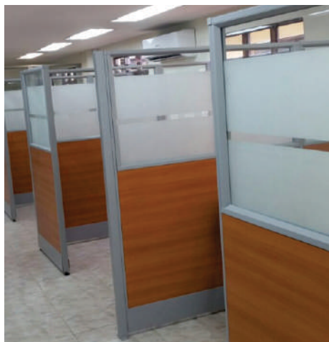
DIVISIÓN MODULAR MIXTA EN RH Y VIDRIO
